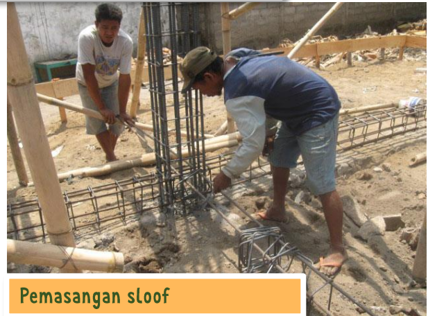
Posisi sloof, pondasi dan kolom
