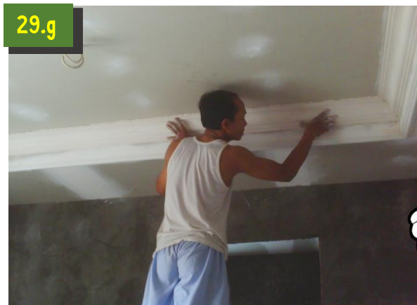
Pasang list plafon secara menerus di ujung langit-langit
