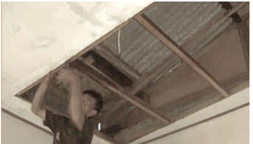
Pasang papan triplek dengan paku ke rangka langit-langit.
