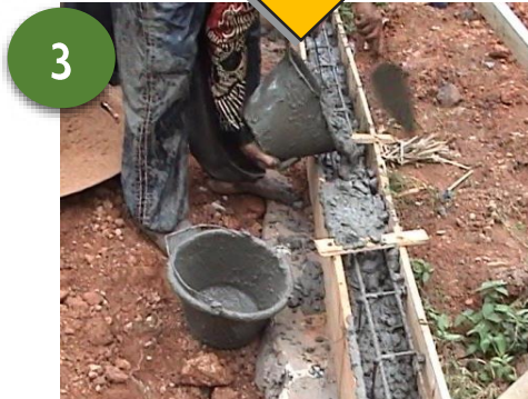
Tuang adukan ke dalam bekisting
